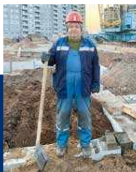
Рассказывает Виктор Масюков, монтажник строительных конструкций 4-го разряда
